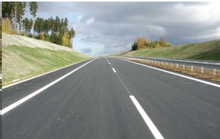
Dokončená levá polovina R6 v zářezu, km 1,800–3,200
