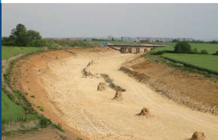
Hluboký zářez v místě, kde má trasu protnout nová vzletová dráha
