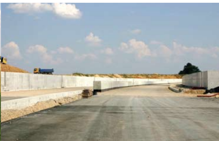
Základy hloubeného tunelu pro umožnění výstavby paralelní dráhy Letiště Ruzyně
